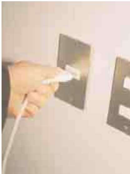
Los fenómenos de autoinducción provocan chispazos (ionización de las moléculas del aire circundante) en los interruptores durante la desconexión debido a la aparición de una diferencia de potencial entre los bornes del interruptor.
